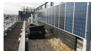
Toit végétal et panneaux photovoltaïques
