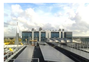
Sky Campus dispose de 1100 m 2 de panneaux photovoltaïques
